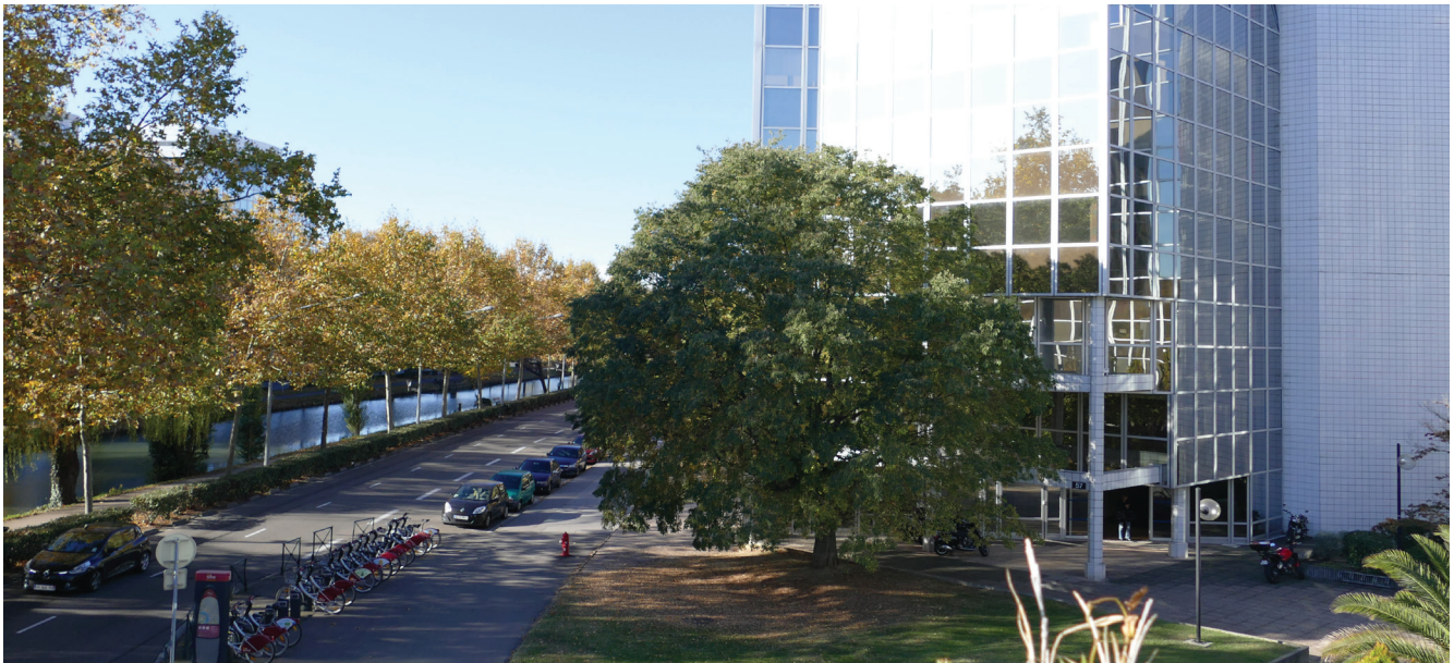
CMP CATT Pont des Minimes - secteur 3
